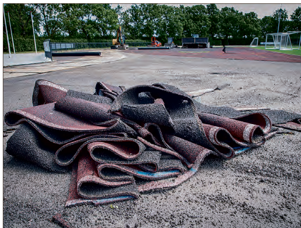
PÅ PLADSERNE-FÆRDIGE-LØB. Renoveringen af Herlev Atletikstadions løbebaner er snart ved at være i mål. Foto: Henrik Lüthcke
